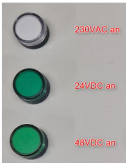
Die 3 Kontrollleuchten zeigen einmal das 230V eingeschaltet sind und ob die beiden Netzteile ihre Ausgangsspannung abgeben.
